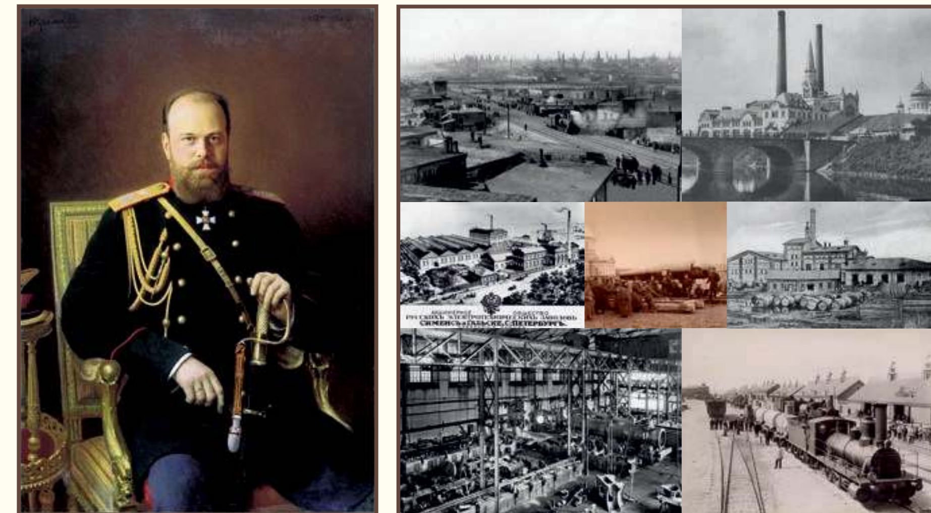
Строительство железнодорожных путей сообщения
